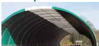
Plane mit 2,50 m breitem Lichtband am First.
