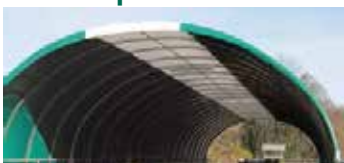
Plane mit 2,50 m breitem Lichtband am First.
