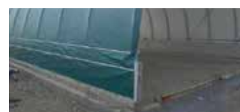
Überlappung bei Montage auf eine Mauer/Betonformsteine
