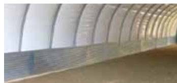
Schutzblech an der Innenwand 0,90 / 1,70 / 2,50 m hoch
