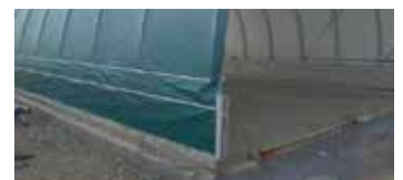
Überlappung bei Montage auf eine Mauer/Betonformsteine
