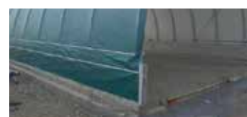
Überlappung bei Montage auf eine Mauer/Betonformsteine
