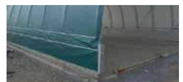
Überlappung bei Montage auf eine Mauer/Betonformsteine
