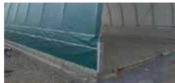
Überlappung bei Montage auf eine Mauer/Betonformsteine
