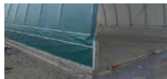
Überlappung bei Montage auf eine Mauer/Betonformsteine
