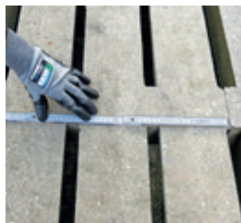
Der Spaltenboden wird vermessen.
